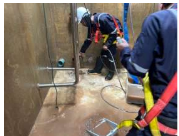
การล้างถังเก็บน้ำใช้ชั้นดาดฟ้า ภาพที่ 2-24 การล้างถังเก็บน้ำใช้ของโครงการ
